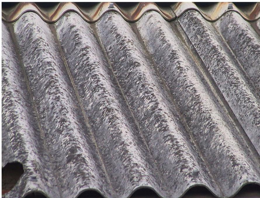
Fig.2 Copertura in cemento amianto
