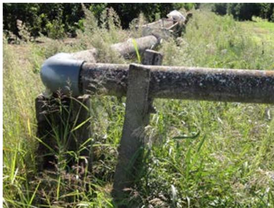
Foto D – Tubo in cemento amianto in superficie che collega le estremità di canalette per il trasporto dell'acqua
