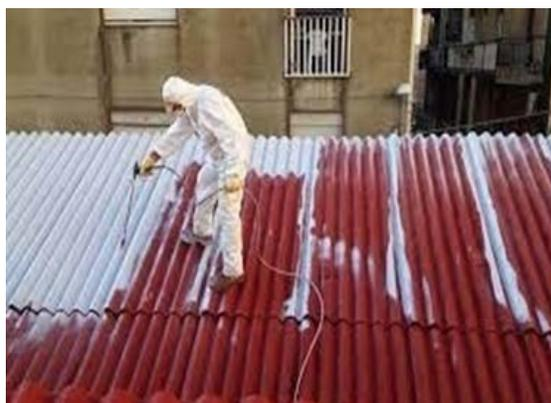
Nella prima fase, viene steso un primer penetrante fissativo con resine sintetiche a base d'acqua. Tali prodotti acquosi hanno un impatto ambientale nettamente minore rispetto ai comuni solventi. La principale funzione di questo primer è quella di penetrare in profondità creando una superficie aggrappante.
