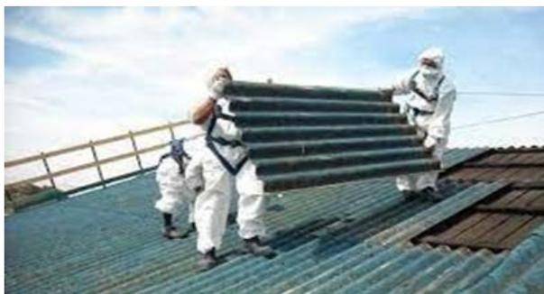
La rimozione prevede l'asportazione totale del materiale contenente amianto. Questo tipo di bonifica elimina ogni potenziale fonte di esposizione. Questo comporta un rischio per i lavoratori addetti e per la contaminazione dell'ambiente, e produce rifiuti tossici e nocivi che devono essere correttamente smaltiti. In genere richiede l'applicazione di un nuovo materiale, in sostituzione al MCA precedentemente rimosso con un materiale non pericoloso. Il
