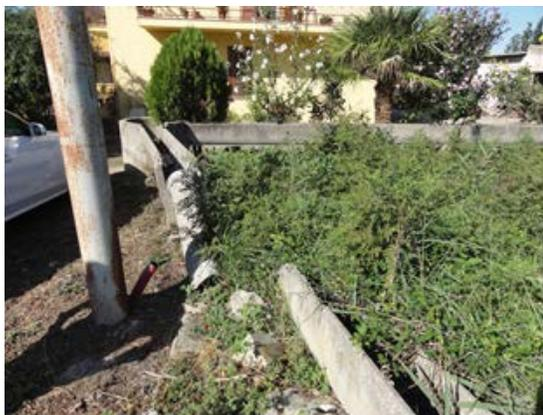
Foto C – Tubo in cemento amianto in superficie, disconnesso ed in stato di degrado, nelle vicinanze di un'abitazione
